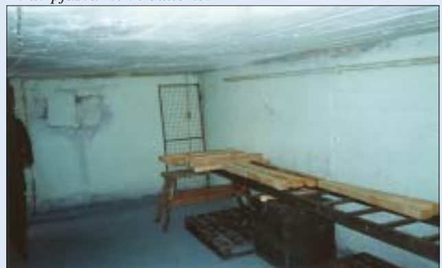
Skyddsrum i batteriet med ny användning
