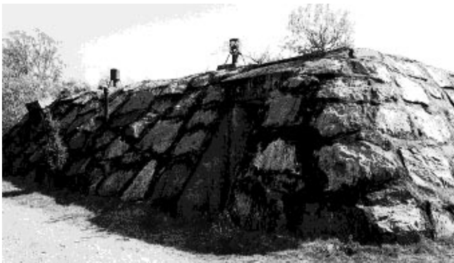
Skyddsrum Killeberget, Östra Hästholmen
