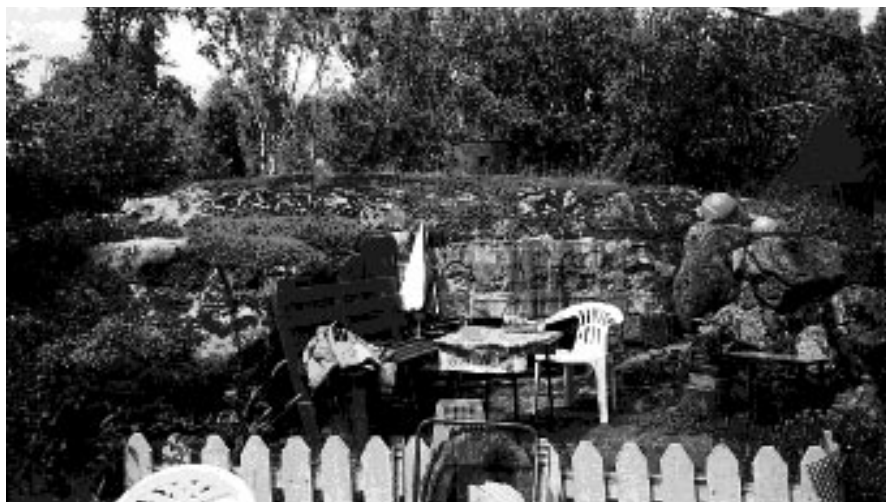
Kulsprutevärn Millegarne västra. I dag privat källare
