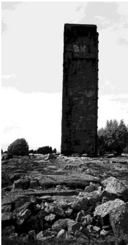
Almö torn. Mätstationstorn batteri Aspöberg
