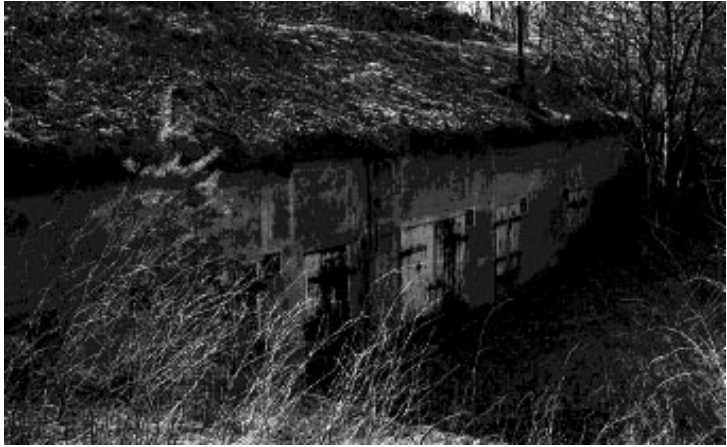
Batterivärn Bollösund, Aspö
