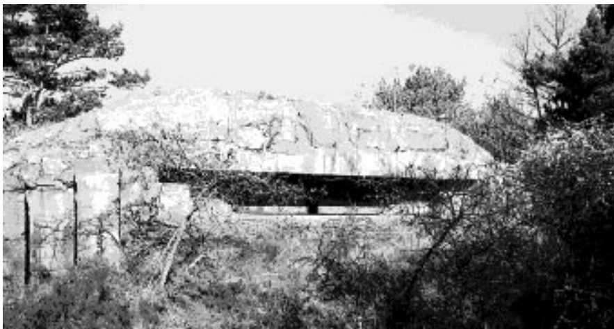
Pjäsvärn batteri Långören
