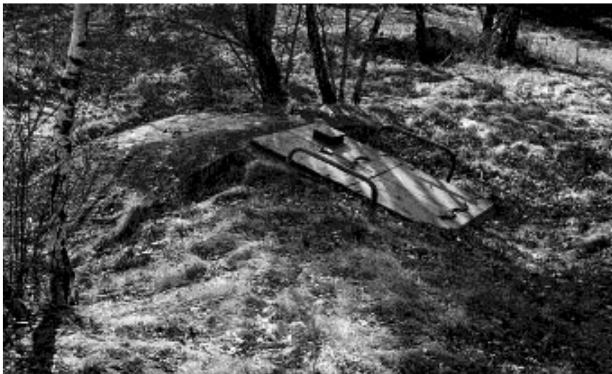
Nedgångslucka batteri Ellenabben, Aspö
