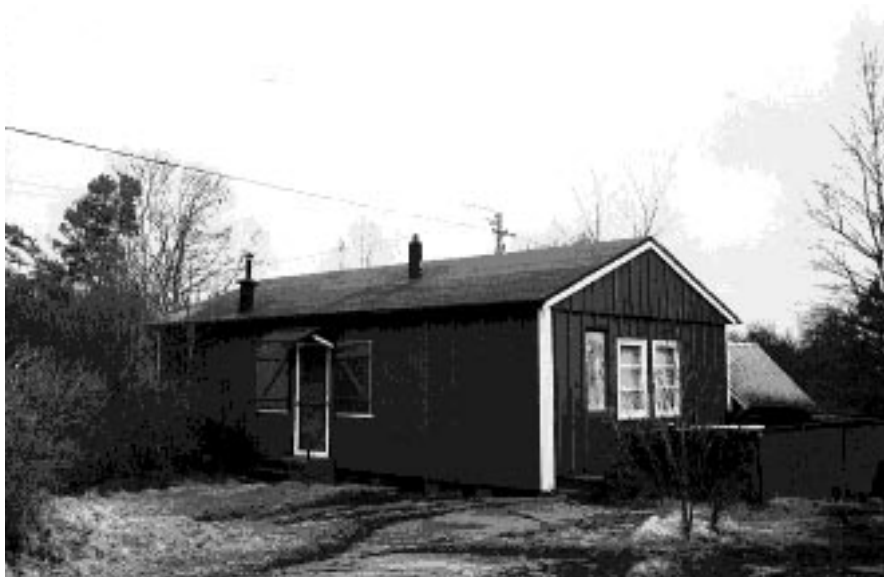
Förläggingsbarack Sandviksvägen, Hasslö. I dag i privat ägo
