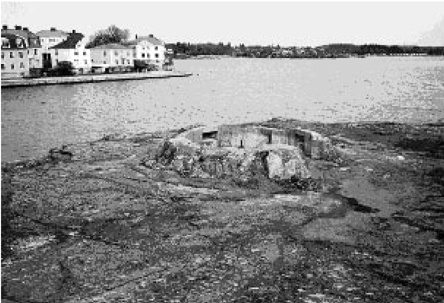
Pjäsplats luftvärnspjäs Stakholmen
