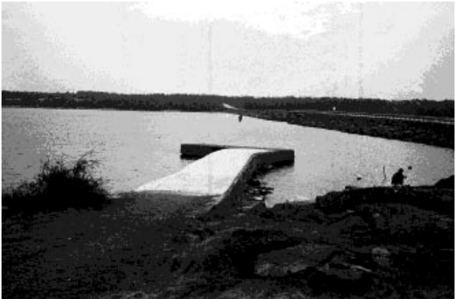
Djupasundsbron, byggd på gammal försänkning
