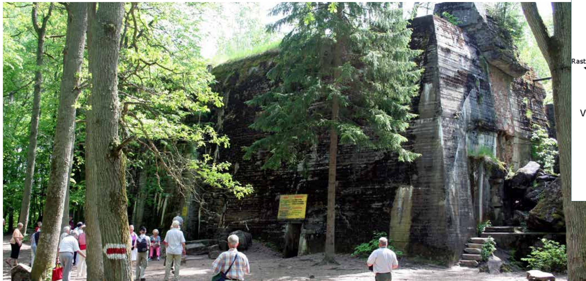
Hitlers bunker där han arbetade och bodde i över 800 dagar. Taket var fyra meter tjockt, väggarna fem meter tjocka och nergrävda sju meter under markytan.
