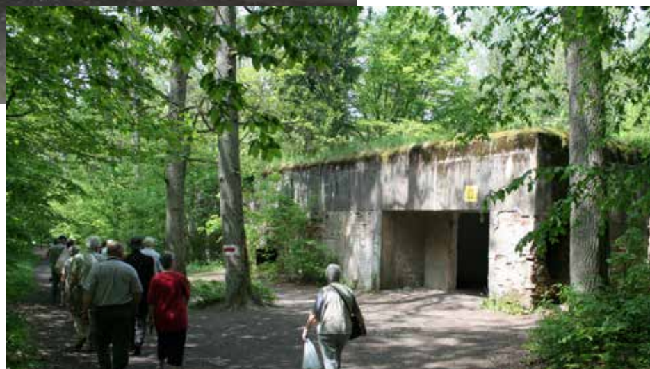
Även garaget för bilarna hade metertjocka betongväggar och tak.
